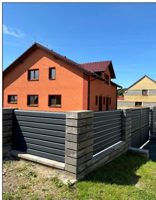
Realizace plotu u rodinného domu Provedení ROM 1
